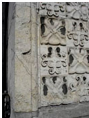
Izquierda: Deterioro de la caliza de la portada, con procesos de arenización y formación de costras negras. Centro: Desconchaduras producidas por impactos de proyectiles en el paramento de caliza. Derecha: Desplacado y arenización de un sillar de caliza.
