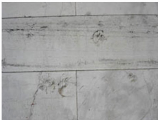
Izquierda: Deterioro de la caliza de la portada, con procesos de arenización y formación de costras negras. Centro: Desconchaduras producidas por impactos de proyectiles en el paramento de caliza. Derecha: Desplacado y arenización de un sillar de caliza.
