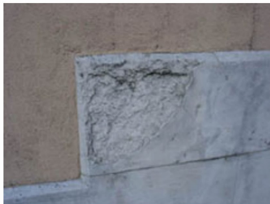
Izquierda: Deterioro de la caliza de la portada, con procesos de arenización y formación de costras negras. Centro: Desconchaduras producidas por impactos de proyectiles en el paramento de caliza. Derecha: Desplacado y arenización de un sillar de caliza.
